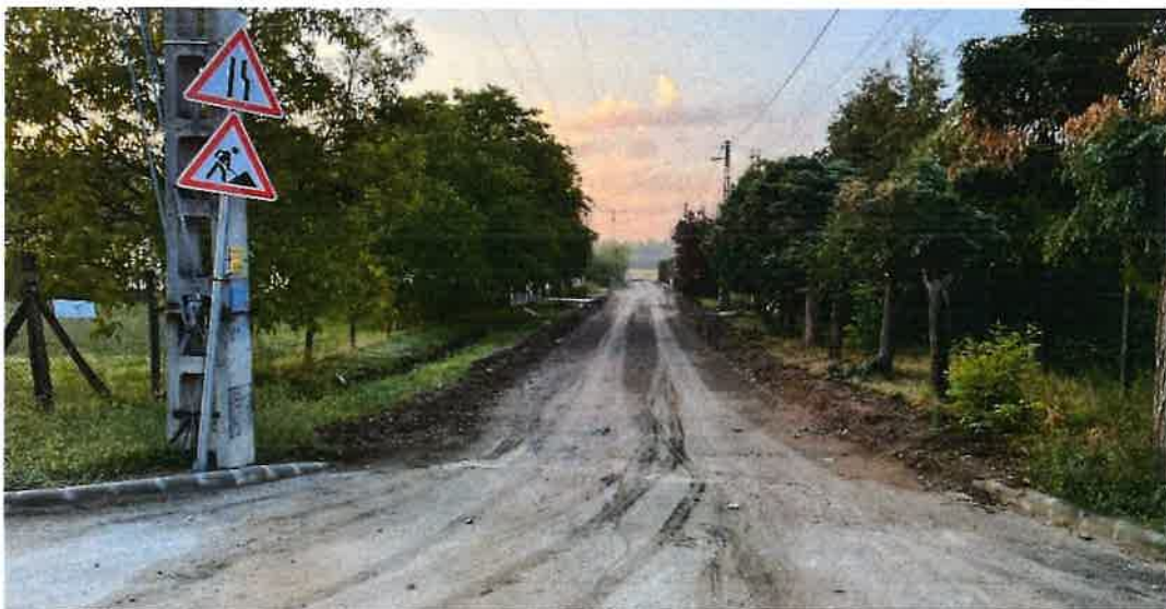
28. kép: Szőlősor utca a burkolatépítés idején
