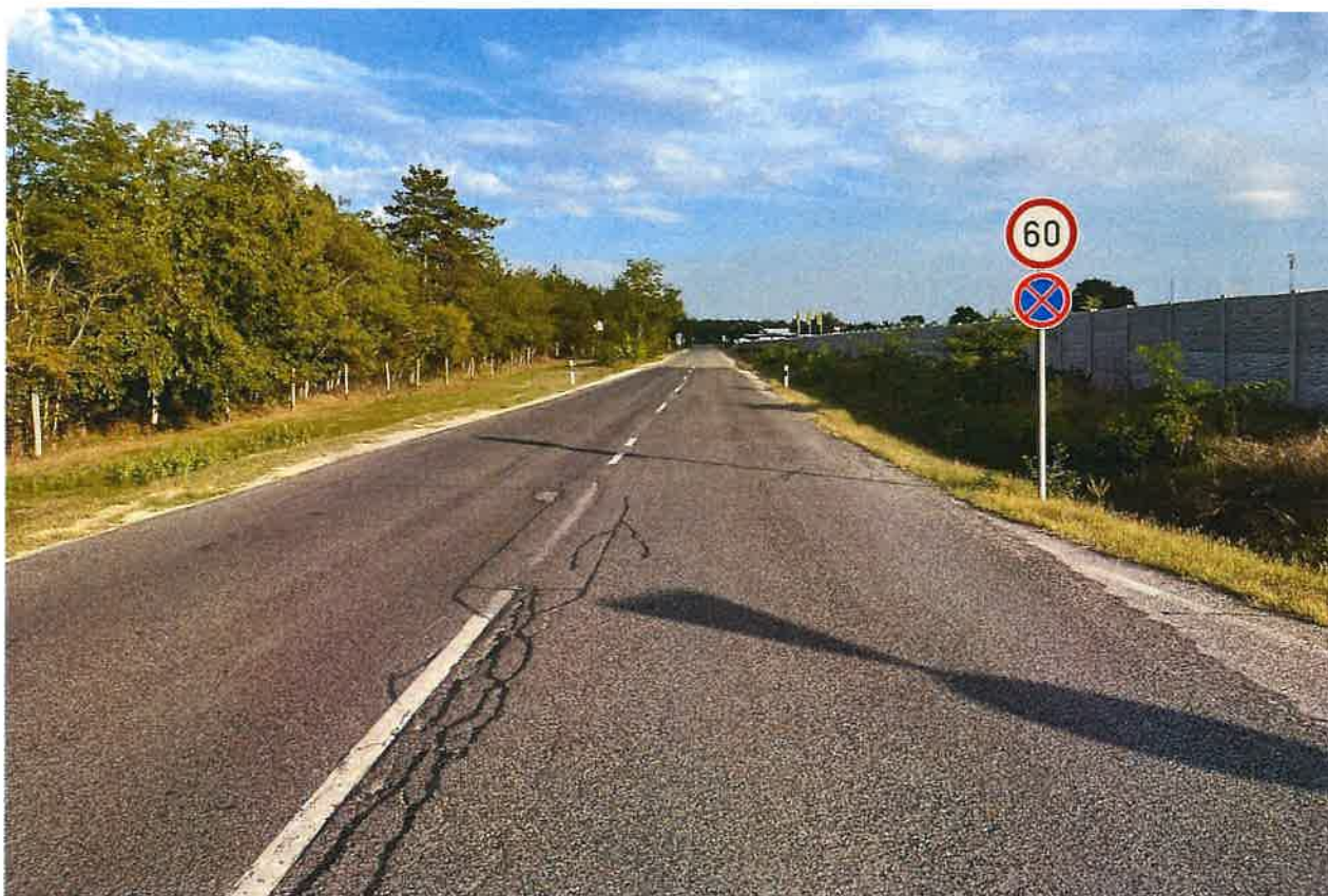
41. kép: Inárcs 0173/9 hrsz-ú út AKA Zrt. által kezelt szakasza
