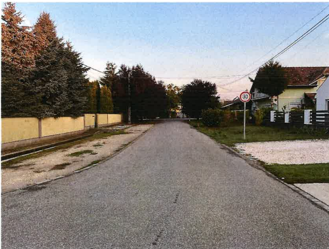
16. kép: Hársfa utca szilárd burkolatú szakasza a Sportcsarnok irányából
