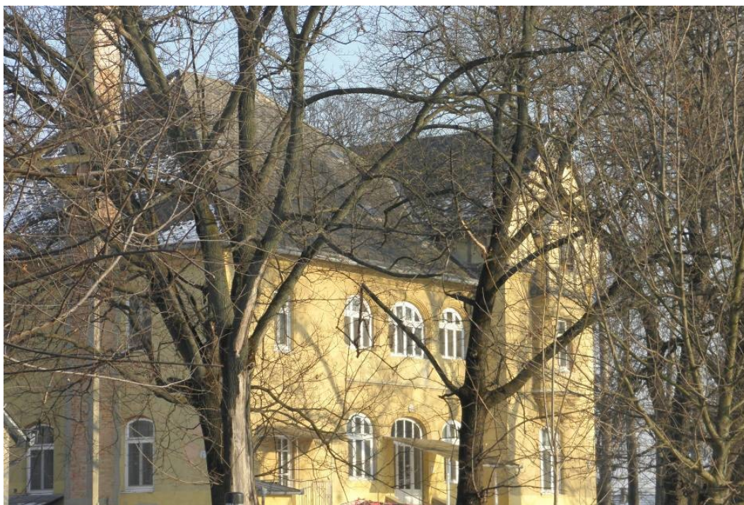
megnevezés: Tolnay-kúria (szociális otthon) épülete cím: Inárcs, Dózsa György u. 329 hrsz. jellemző: eklektikus stílus értékek: épülettömeg, homlokzatképzés, eszmei érték datálása: 1960-as évek
